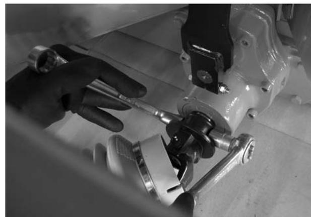
**Figura 4:** Fissare l'albero cardanico
